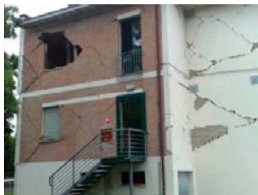
I danni provocati dal terremoto alla scuola vecchia di Rovereto sulla Secchia che verrà demolita
