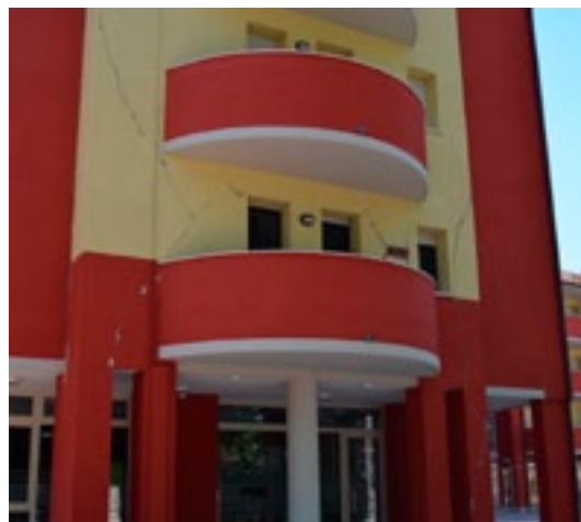
Un edificio nuovo e i segni dei danni subiti
